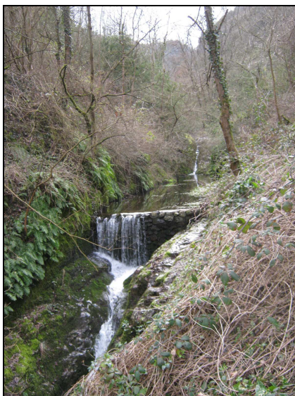
Figure 3-8 : Zone amont très engorgée du Vergelet
