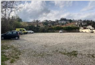
Parking en stabilisé de l'OAP
