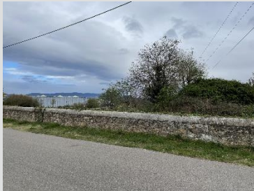
Un des murets en pierre à conserver
