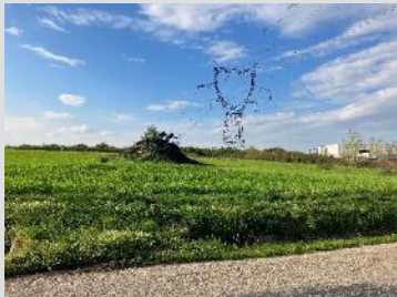
L'OAP et le pylône de ligne à haute tension depuis la route D271a
