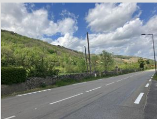
D86 et mur en pierre
