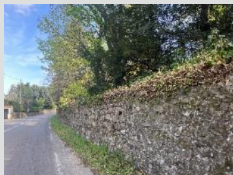
Mur qui borde l'OAP depuis l'Avenue Daniel Mercier
