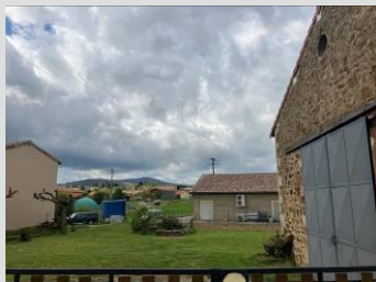
Sud de l'OAP et bâtisse ancienne
