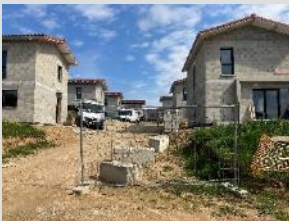
Habitations en construction à l'est de l'OAP
