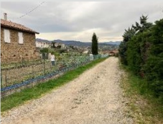
Chemin d'accès en stabilisé
