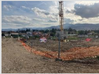
Est de l'OAP en construction
