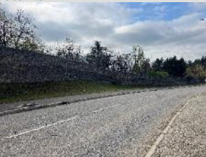
Mur bordant l'OAP depuis la rue de la Lombardière
